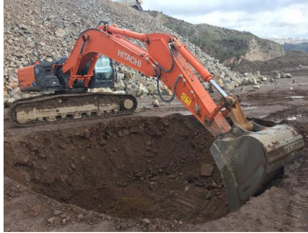
Şekil 7. Ölçümler için sahada yapılan kazı çalışması.
